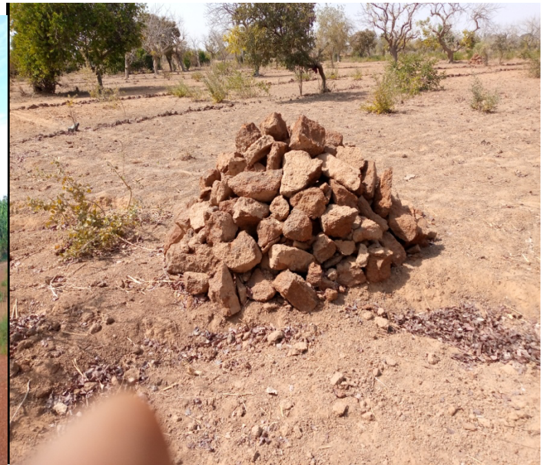
Réalisation des diguettes dans champs
